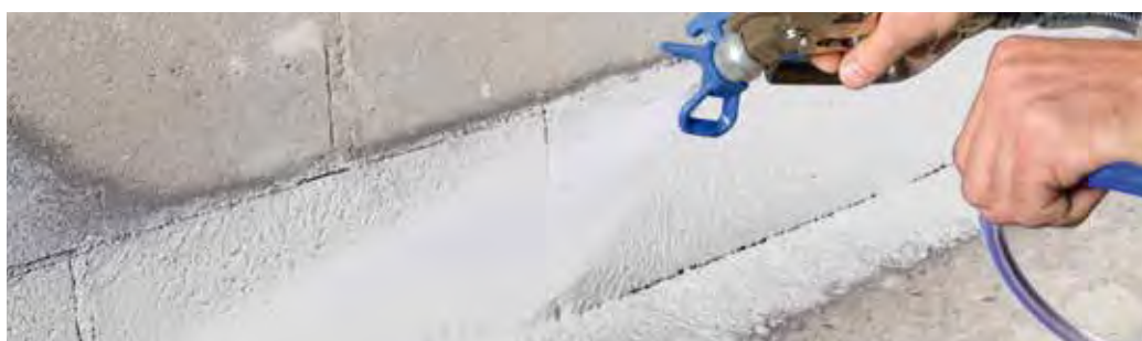
AEROSANA VISCONN/white Spuut-/smeerbare afdichting om oppervlakken en aansluitingen snel luchtdicht te maken, blauw/zwart/wit
