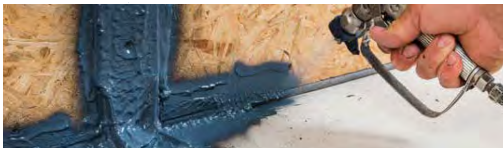
AEROFIXX Persluchtpistool voor AEROSANA-afdichtingsmiddelen in worstverpakking
